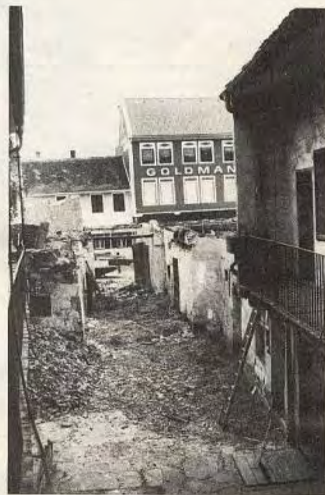
Abbruch der Fleischerei Kern
